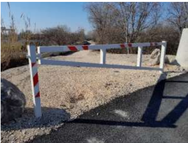
Barrière d'accès à la nouvelle voie pompier (clé polycoise)
